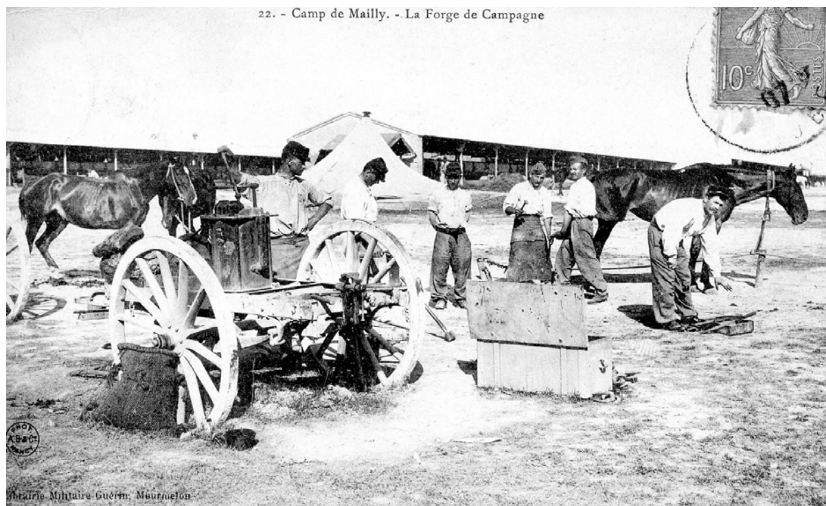
Figure 7 : Forge de campagne, remarquer le charbon, l'étau, la caisse à fers.
